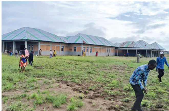
Das aktuell im Bau befindliche Krankenhaus in Tshumbe. Der Rohbau inklusive überdachter Veranda ist abgeschlossen, die Fenster sind eingesetzt. Die Eröffnung ist für Ende des Sommers 2026 geplant.
