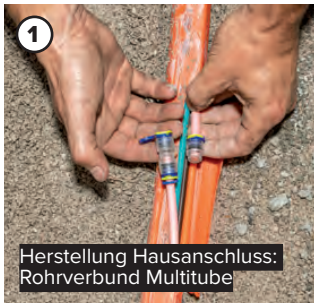
Röhrchen und Glasfaserkabel im Verteilerkasten dem Gebäude zuordnen
