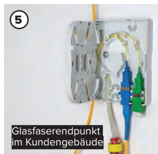
Röhrchen und Glasfaserkabel im Verteilerkasten dem Gebäude zuordnen
